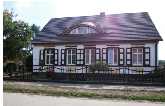
„Historisierender“ Putz am Massivbau (19. Jh.)
