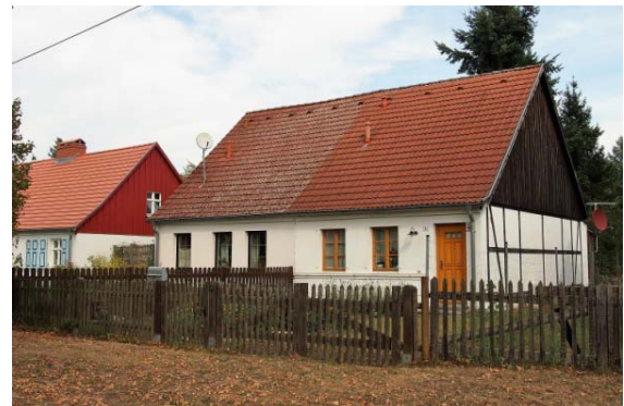
Überputzte Fachwerkfronten und erhaltene bzw. farblich neue Holzverschalungen im Giebelfeld
