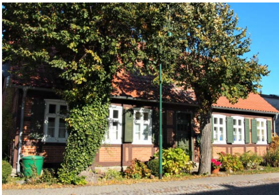
Ein vorbildlich und schön saniertes Fachwerkaus
