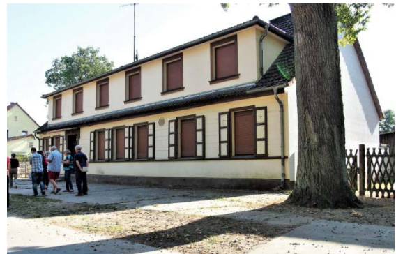
Dachgaube entstellt historische Gebäudeform
