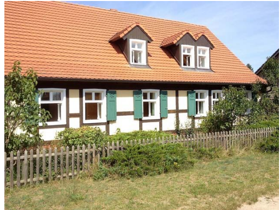
Eine „das Original bewahrende“ Instandsetzung
