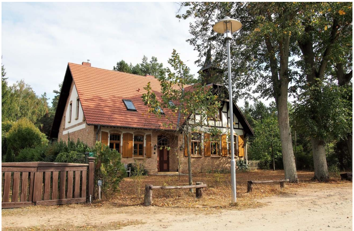
Das Ortsbild prägende und in seiner Kubatur herausragende, denkmalgeschützte alte Schulhaus
