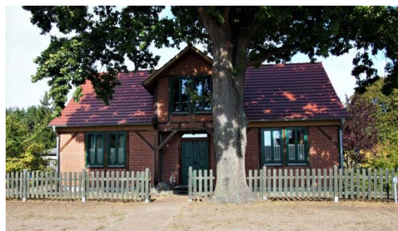
Neubau: In „überlieferter“ ortstypischer Gestalt
