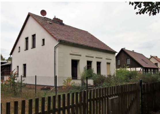
Vorgeblendete, dekorative Putzfassade an der Straßenfront (19./20. Jh.) in harmonischer Farbe
