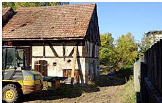
Hofgebäude mit viel Substanz vor der Sanierung
