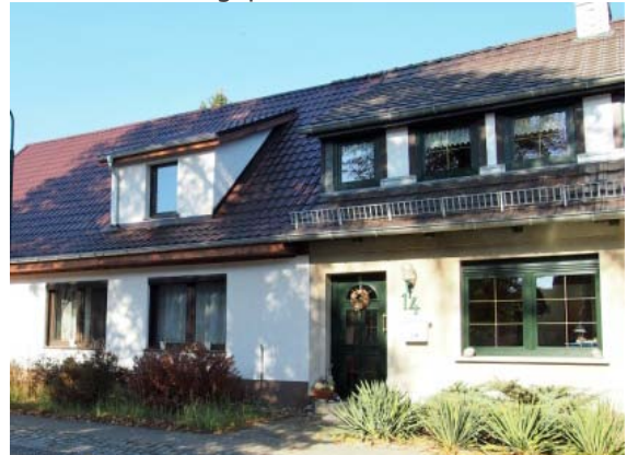
Doppelhaussanierung mit diverser Verfremdung
