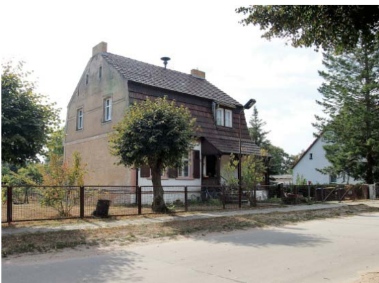
Altbau mit ortsuntypischer Dach-/Gebäudeform
